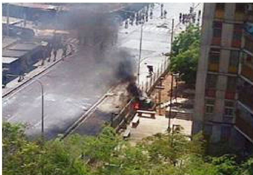
Transformadores de Luz incendiados de las Torres El Saladillo, 15.03.14, Maracaibo.
