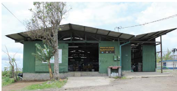
Imagen 2. Fachada del centro de acopio de San Rafael
