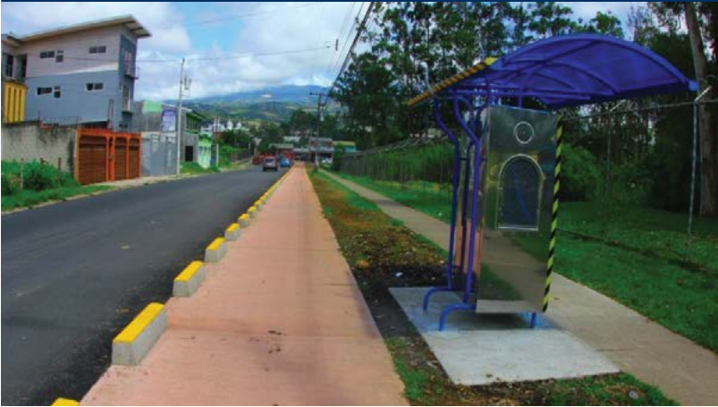
Imagen 2. Conclusión de infraestructura principal de la ciclovía, etapa 1
